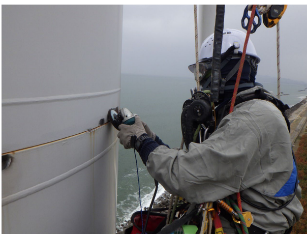
腐食生成物の除去
